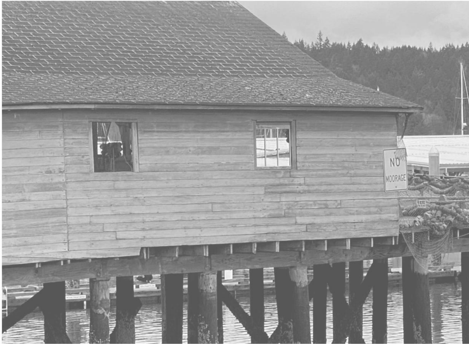
9H DETAILED VIEW SE ELEVATION AT E CORNER SCALE: N.T.S. Image 1
